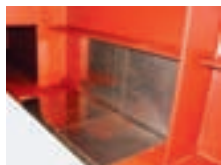
チタン箔の貼付け
